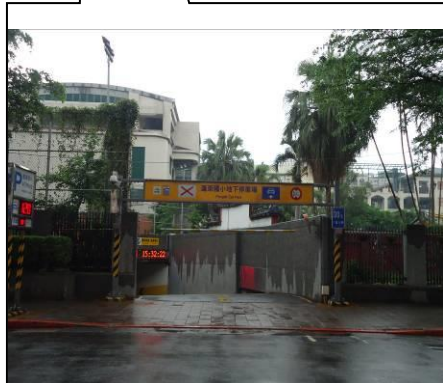
平陽街地下室停車場出入口
