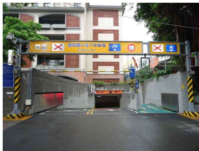
太原路地下停車場出入口，有蜂鳴器和閃光燈號
